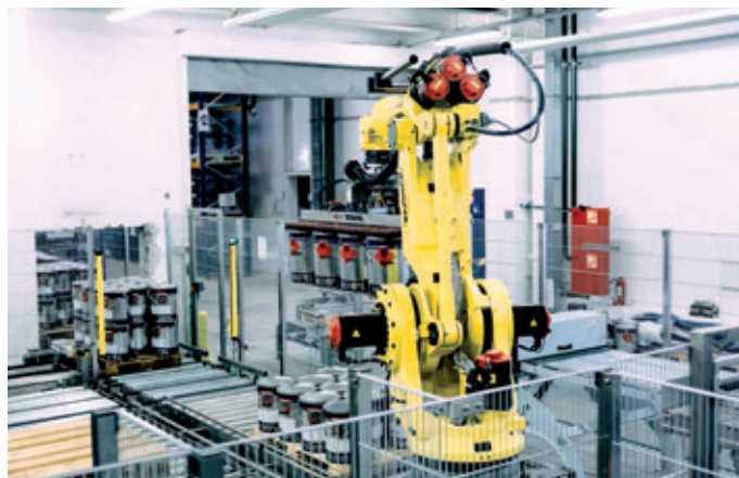
Зона автоматического паллетирования и этикетирования
